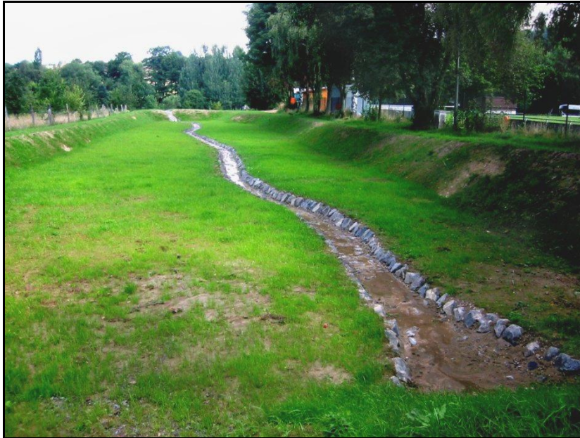
Abbildung 2: Beispiel für ein Regenrückhaltebecken (Quelle: Ingenieurbüro Lorenz)
