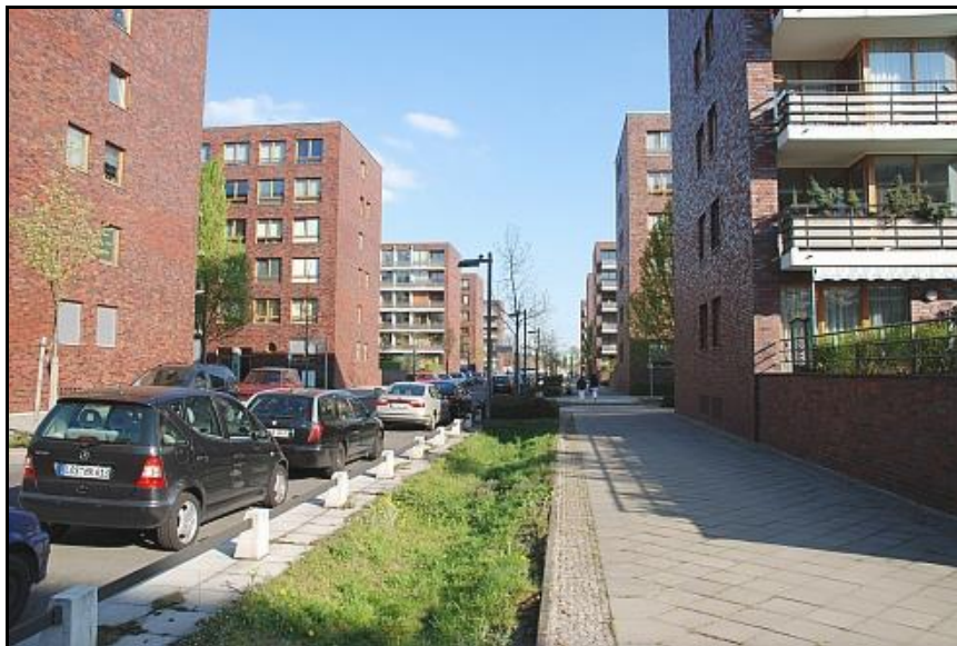
Abbildung 1: Beispiel eines Mulden-Rigolen-Systems in Berlin-Rummelsburg (Quelle: Prof. Sieker)
